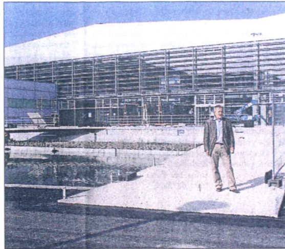
Das Herstellerverkaufszentrum »seemaxx« schaut seiner Vollendung entgegen. Arnold Kannenberg, Geschäftsführer der Hesta, ist sicher, dass bis zum Eröffnungstermin am 26. Oktober alles fertig ist. Am 25. Oktober wird mit über 300 geladenen Gästen die Eröffnung am Abend vorgefeiert. swb-Bild: aj
